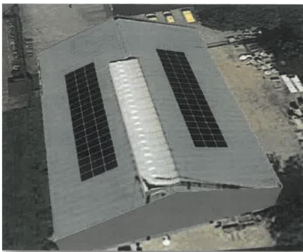
Zonnepanelen op onze bedrijfshal
